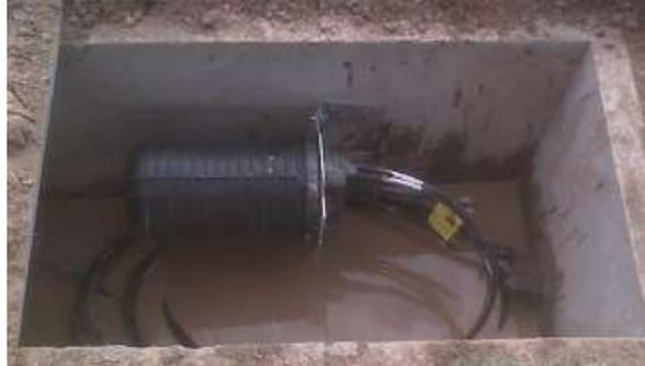
La función que cumple este empalme es acceder con un tipo de cable con cubierta ignífuga al interior del Sitio de ARSAT.
