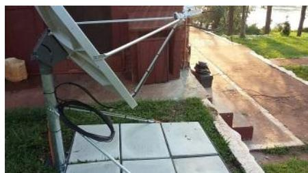
2.25- En zonas con vientos fuertes se deben instalar riendas de acero con el fin de dar más seguridad al ajuste de la antena.
