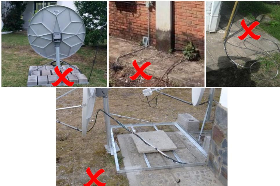
2.20- De realizarse zanjeo en suelo este deberá tener una profundidad mínima de 40-50 cm con el fin de preservar el cable, y en veredas o pasillos su cruce se deberá realizar con cañería amurada, tapada y revocada al ras de suelo quedando reparada con similar condición al inicio del trabajo. Esto garantizará la protección del cable, un correcto trabajo hacia el cliente y la normal circulación de personas.
